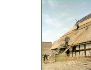
Das Schilfrohr wird in Bündeln auf das Dach gebracht und dicht nebeneinandergelegt, um eine wasserfeste Schicht zu bilden. Ursprünglich waren viele der Häuser mit langhalmigem Roggenstroh gedeckt. Dafür erforderliche Roggensorten werden jedoch nicht mehr angebaut. Deshalb wird heute im Museum Reet als Ersatz für Roggenstroh verwendet.
